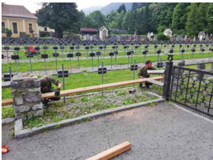
Auch am Soldatenfriedhof Kötschach-Mauthen mussten einzelne Zaunelemente erneuert werden.
