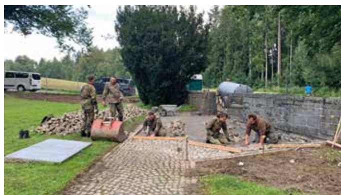
Pflasterungsarbeiten im Eingangsbereich
