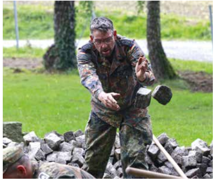
Pflasterarbeiten im Eingangsbereich
