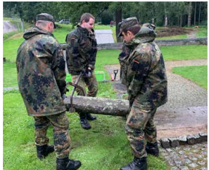
Neubefestigung der Stufenplatten
