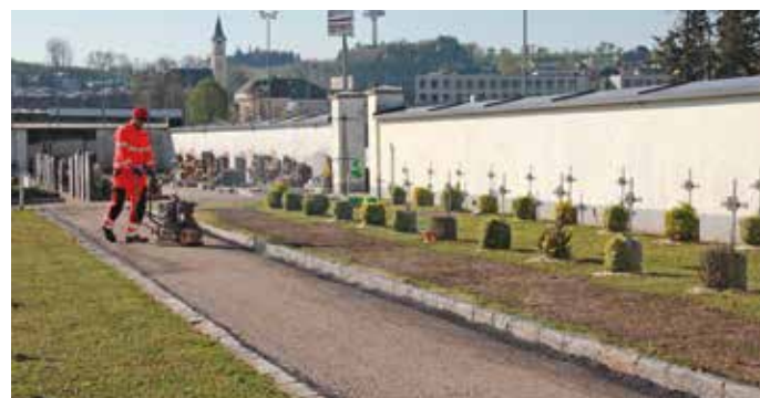
Bauhofmitarbeiter Britto Gutmann beim Asphaltieren des Weges
