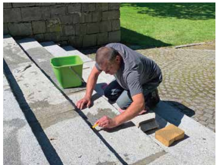
Friedhofsbetreuer Werner Eibensteiner beim Ausfugen der Treppenstufen
