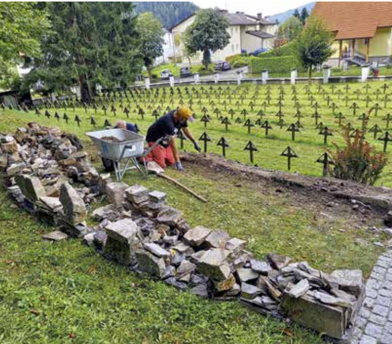
Sanierung der Stützmauer beim zentralen Mahnmal
