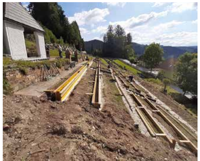
Erneuerung der Fundamente für die Grabkreuze
