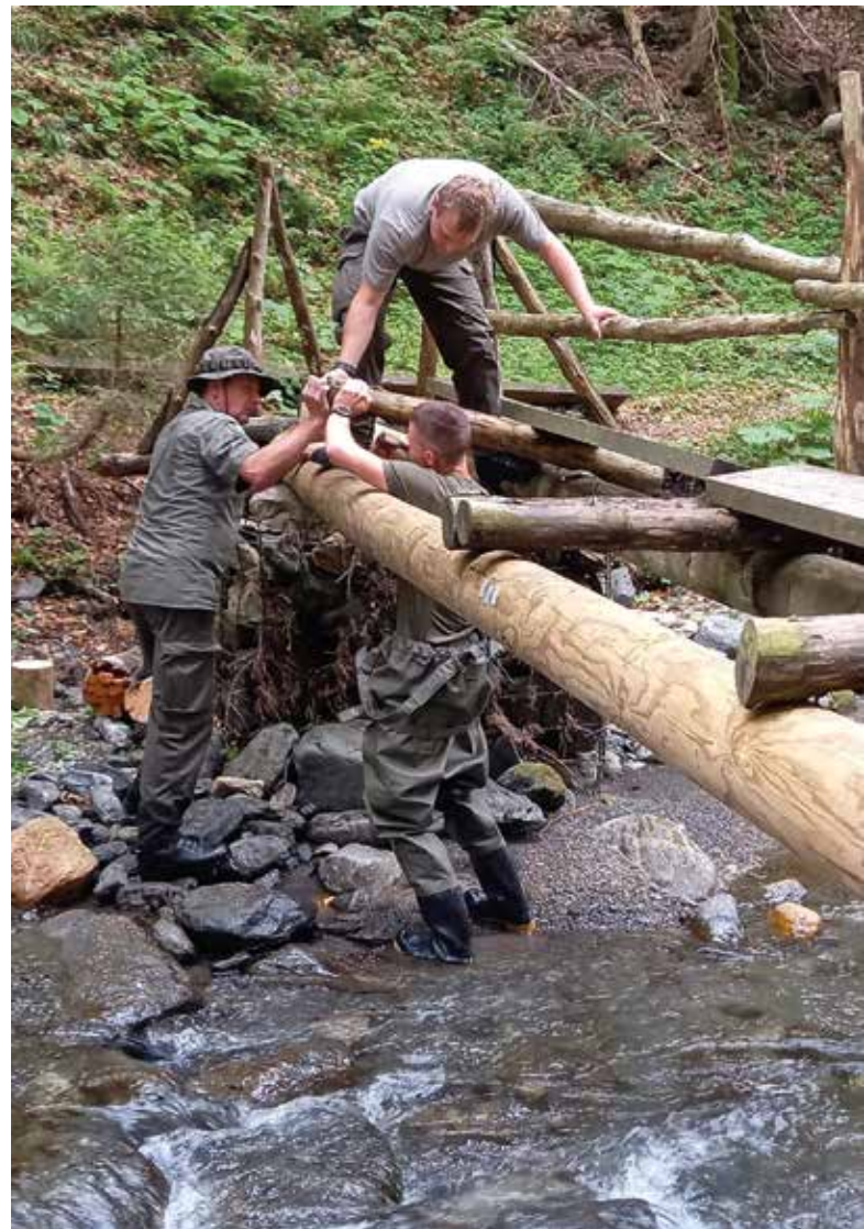
Auswechslung der kaputten Längsträger bei der Brücke über den Angerbach
